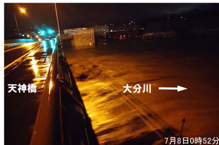
天神橋地点出水状況写真
