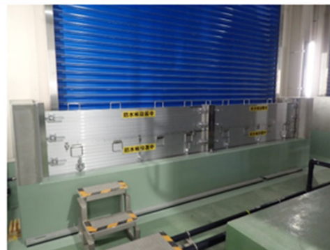
浄水場の浸水対策(止水板の設置)(大分市)
