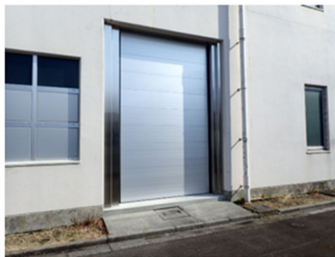
浄水場の浸水対策(防水シャッターの設置)(大分市)
