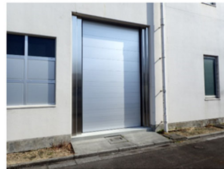
防水シャッターの設置
