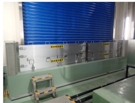
止水板の設置
