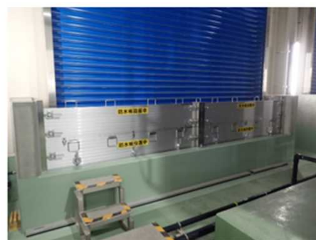
止水板の設置
