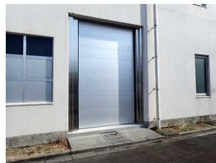
防水シャッターの設置
