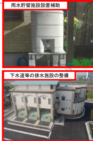
雨水貯留施設設置補助
