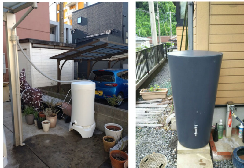
雨水貯留タンク設置例
