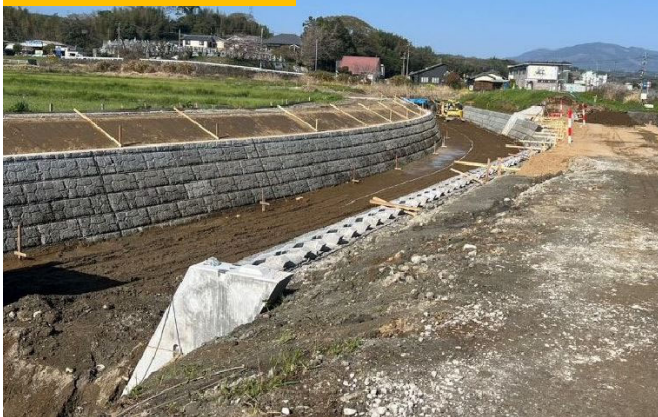
令和4年度の取組 ・河川改修工事
