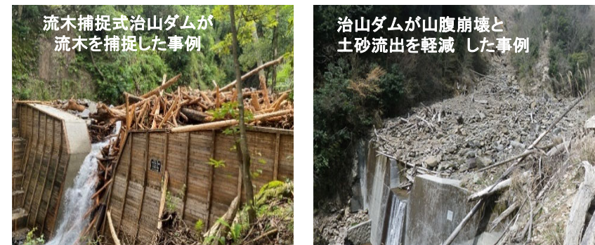
治山事業の実施による流木・土砂の流出抑制効果
