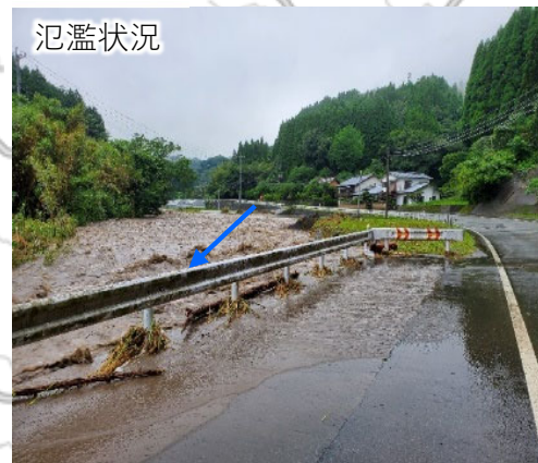
被災状況写真
