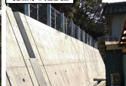
令和6年度の実施 急傾斜地崩壊防止施設の整備
