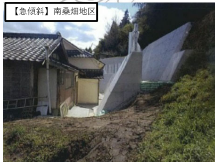
令和6年度の実組 急傾斜地崩壊防止施設の整備
