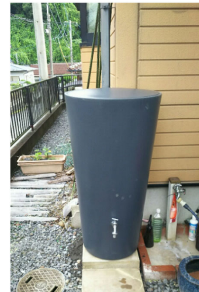
雨水貯留タンク設置例
