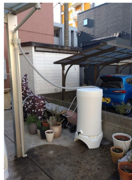
雨水貯留タンク設置例
