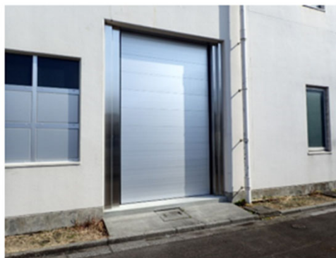
防水シャッターの設置
