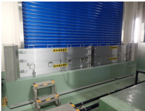
止水板の設置
