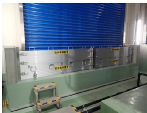
止水板の設置
