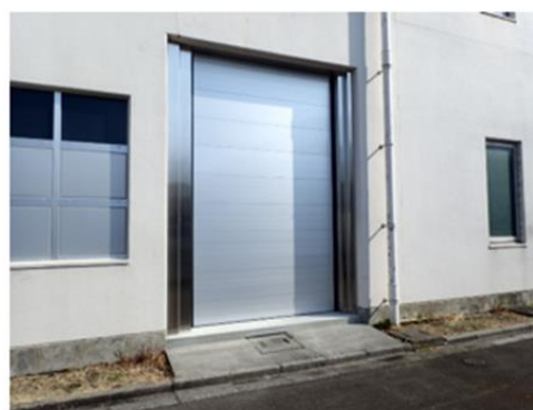
防水シャッターの設置
