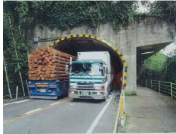
▲(坑口)大型車のすれ違い状況
