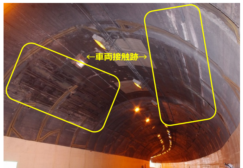
トンネル内部での車両接触状況
