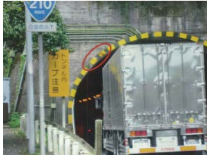
▲(坑口)大型車のトンネル進入状況
