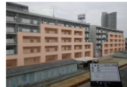
▲外付けフレーム耐震補強
