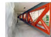
鉄骨ブレースによる壁の補強
