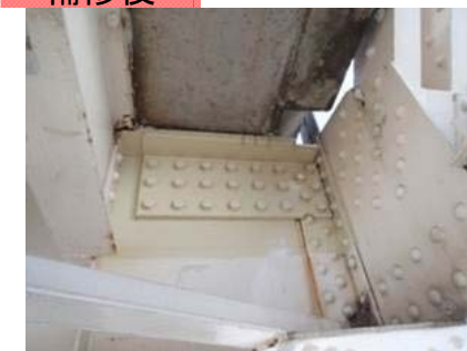
損傷(亀裂)箇所の補強
