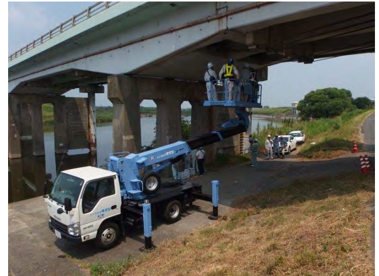
高所作業車による点検状況
