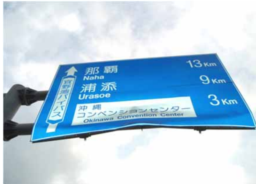
異常変形 (車両衝突)
