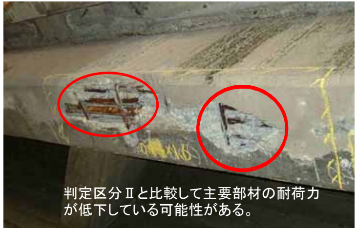
判定区分Ⅲ(主桁の断面欠損)
