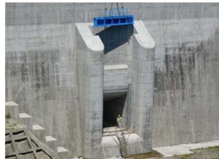
大分川ダムの仮設オリフィスゲートは5枚で構成されており、上の写真は最後の1枚が撤去される様子です。
