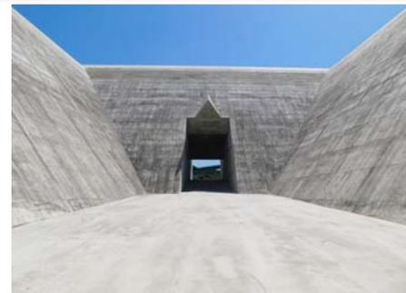
洪水吐の内側から常用洪水吐を撮影しました！穴の開いた常用洪水吐と三面越流方式の非常用洪水吐からなる自然調節方式ダムです。試験湛水が問題なく完了できるよう皆様のご協力の下頑張っていきます。
