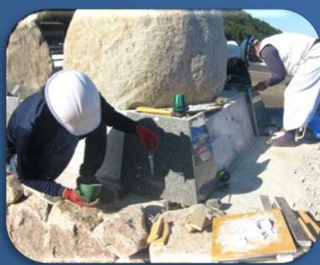
《基壇石材加工・石張り》
