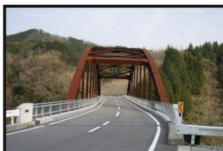
現在の尾原橋
