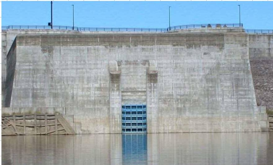
型 式 プレートゲータ構造角落しゲート
