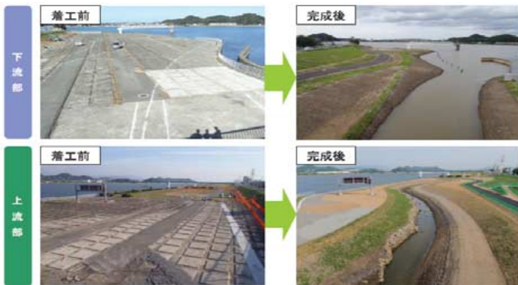
多自然魚道（せせらぎ水路・干潟）の施工前後の状況
