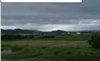
尺岳川浄化施設
