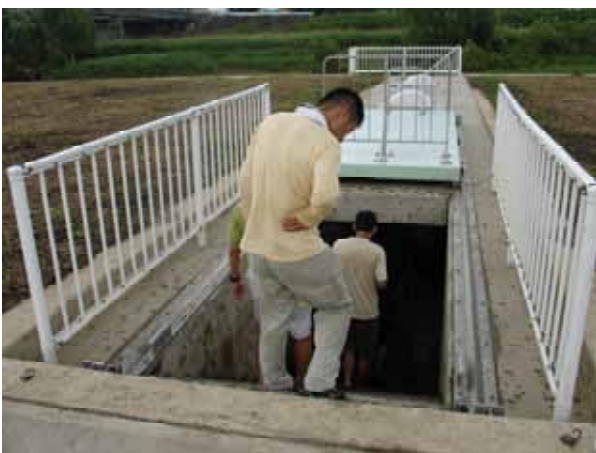
( 熊添川浄化施設を見学 )
