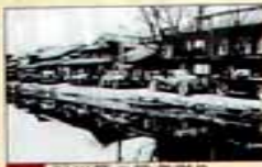
C 堀川橋の校舎廻り 堀川橋は、江戸時代から続く古くからの橋で、現在は農業用水として利用されている。
