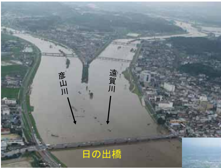
7.25撮影 遠賀川・彦山川合流点
