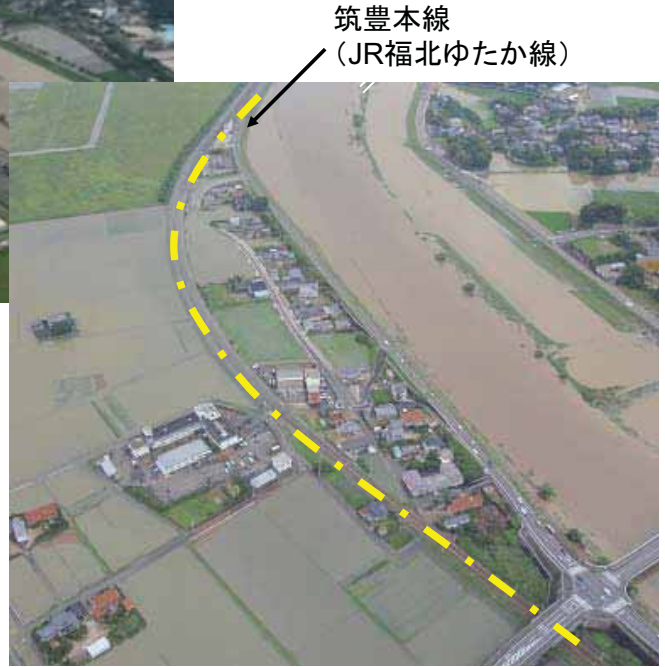
7.25撮影 遠賀川左岸24k付近 小竹地区ではJR線が冠水
