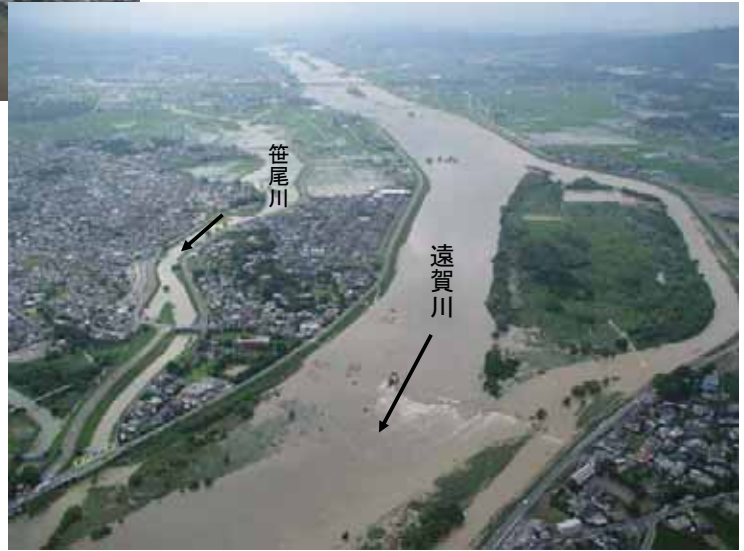
7.25撮影 遠賀川・笹尾川合流点
