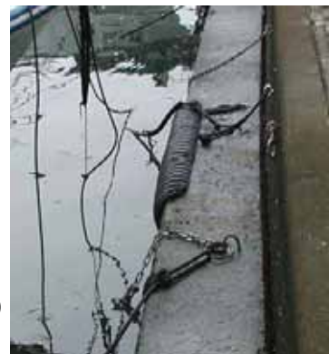
係船柱 船をつなぐための柱 (50cm~80cm) が多い
