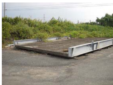
西川右岸1.6km付近にある棧橋
