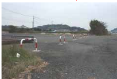
駐車スペースを制限するために車止めを設置
