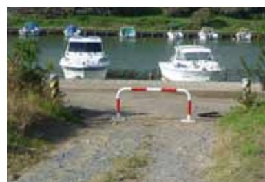
車止めなどの設置によるアクセス制限の実施
