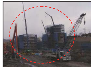
堰本体のコンクリート堰柱を打設しています。
