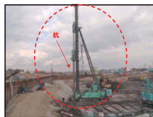
堰を支える杭を河床に設置しています。
