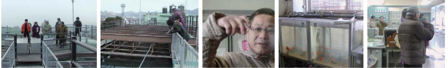
沈殿池で細かな砂やゴミを取り除き、急速ろ過池で水をこします。 原水の水质を検査、薬品検査(左)、金魚で水质管理(右) 浄水場を操作する管理室
