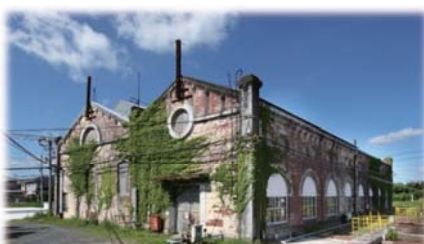
遠賀川水源地ポンプ室(中間市土手ノ内)
