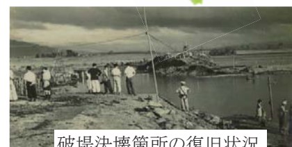
破堤決壊箇所の復旧状況
