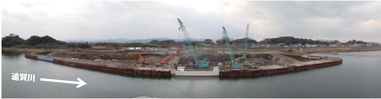
締切内での工事の様子（平成28年1月撮影）
