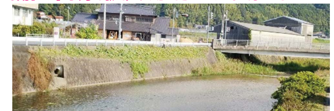
護岸の草を刈り取り、すっきりきれいになりました
