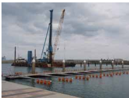
オーナーバース(2基目を工事中(写真奥))
