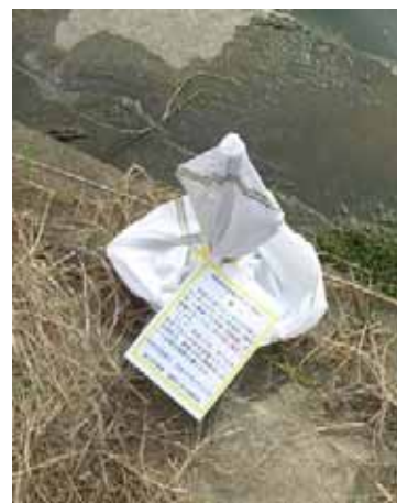
警告した係船柱を利用できないように「土のう袋」を巻き付け、さらに警告 (平成23年9月設置・今後撤去予定)
