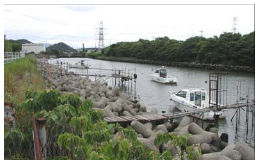
写真-4 江川における係留状況
