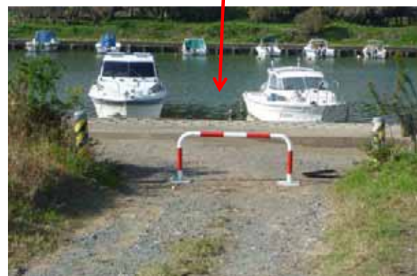
車両進入規制の設置
