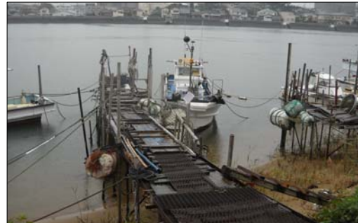
写真-2 遠賀川における係留状況
