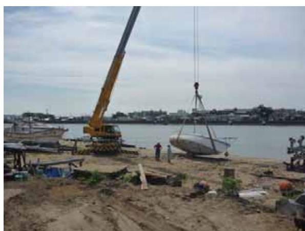
遠賀川高水敷での自主撤去状況(船舶)
