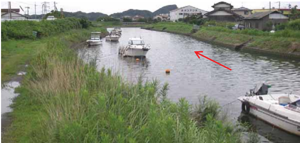
写真⑧ 戸切川・左岸・若松橋下流付近
