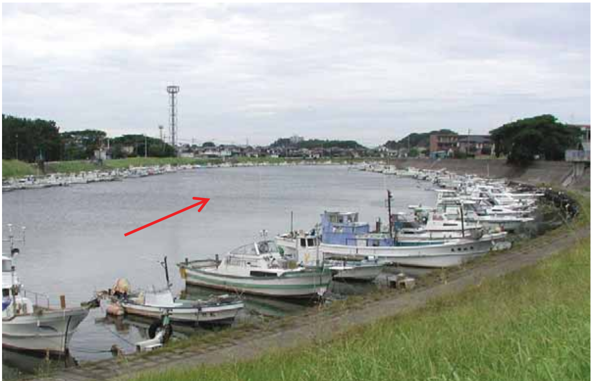
写真① 西川・右岸・遠賀川合流点から約 1.0 km付近
