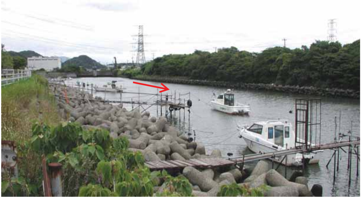
写真⑦ 江川・右岸・遠賀川合流点から約 0.9 km 付近
