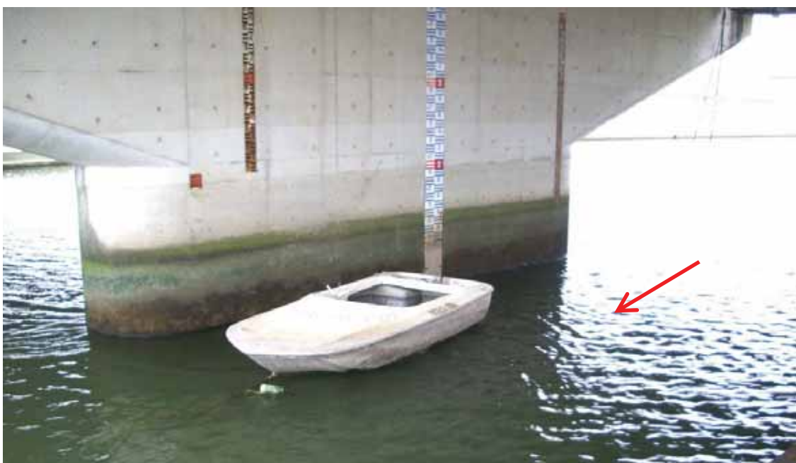
写真④ 西川・右岸・遠賀川合流点から約 5.3 km付近
