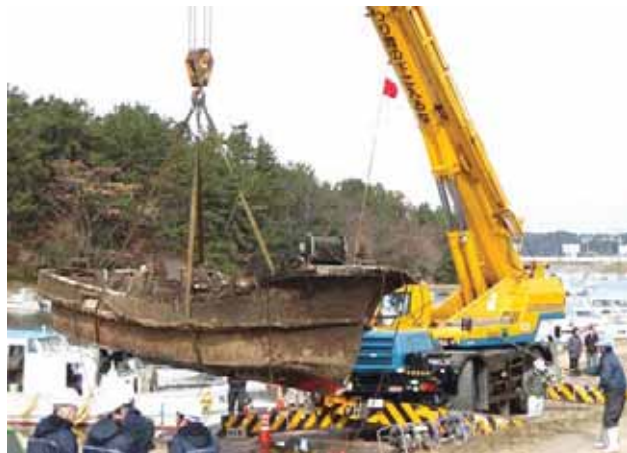
遠賀川における行政代執行 (平成20年2月)
