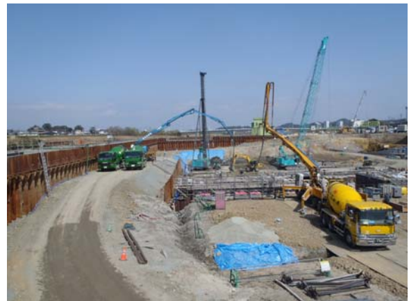
コンクリートの流し込み堰を作ります。
