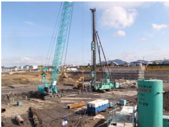
堰を支えるコンクリート基礎の設置します。
