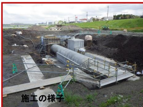
掘削、管据付けのための作業を実施中
