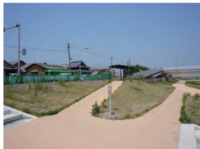
完成したスロープ付き階段。車いすを利用する人でも自力で上り下りができるよう、スロープの勾配を8%としています (2013年5月)
