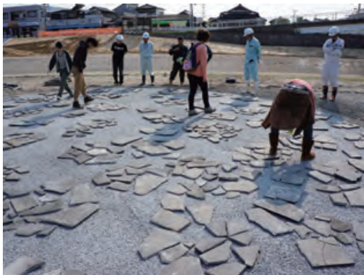
割った鉄平石を数個つなげて、クラック（隙間）の入った様々な形のかたまりを形成します
