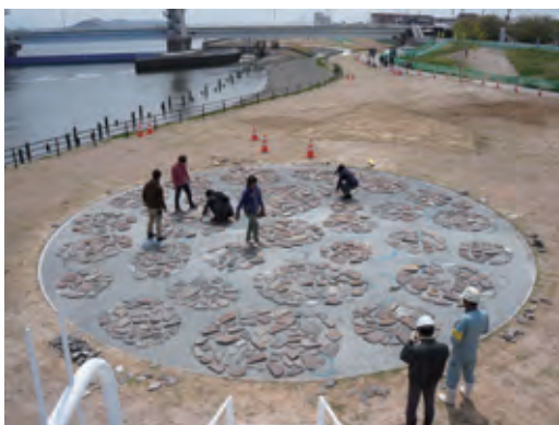
転回場に鉄平石を配置する作業の様子
