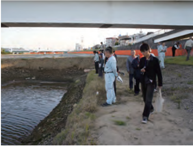
住民ワークショップ参加者は、整備途中の多自然魚道の法面勾配や水際を中心に現場見学をしました。
