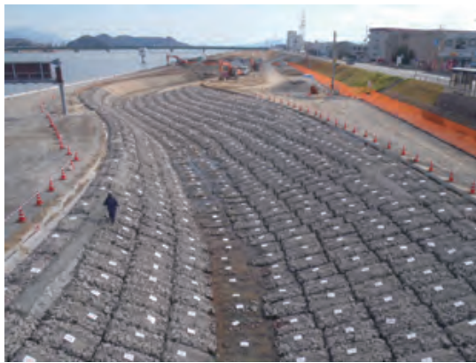
多自然魚道の下には約 2000 個のコンクリートのユニットが設置されています
