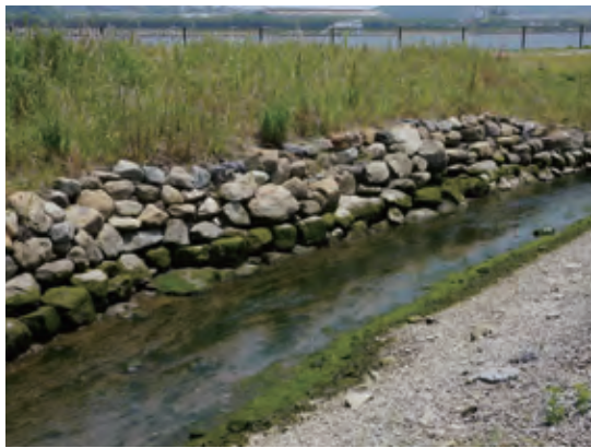
天然石を再利用した石積み。形の違う石を組み合わせています
