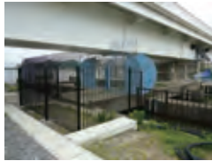
侵入防止柵（既設魚道）
