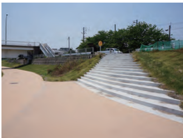
完成した下流側階段。遊歩道との接続部がなめらかになるように工夫がされています (2013年5月)
