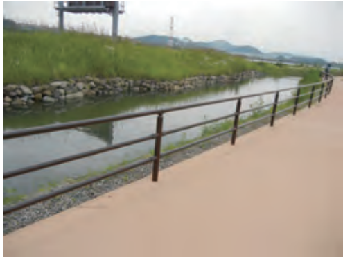
侵入防止柵（散策路）
