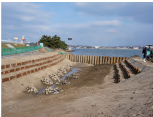
矢板で水をせき止めながらの施工 (2013年2月)
