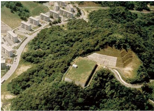
日峰配水池 北九州市八幡西区大字浅川
