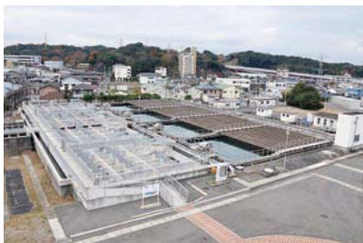
フロック形成池・沈でん池
