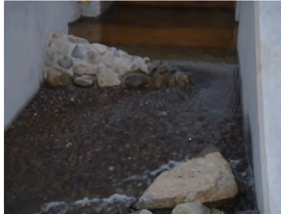
多自然魚道内
