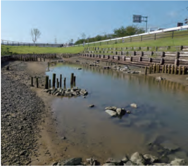
入江干潟の施工では、干満による水位の変動を見ながら、石の配置を何度も手直ししていきました
