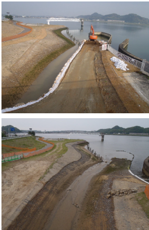
下流取り壊し
