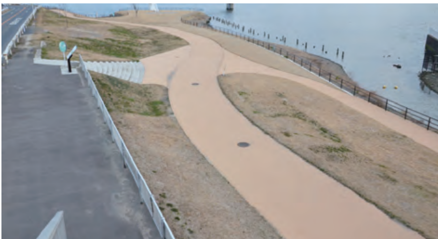
サイクリングロードと遊歩道がつながる部分。違和感なくめらかなにすりつけられるように施工しました
