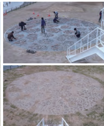
転回場の製作と完成写真
