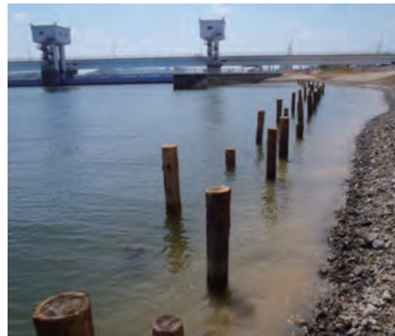
黄金比 (=1:1.618) を参考にして配置された杭。水面に出た杭の長さで、現在の水位がどの程度なのかを知ることができます
