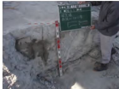
固定堰の取り壊し
