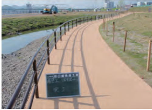
防護柵とカラー舗装された管理用通路
