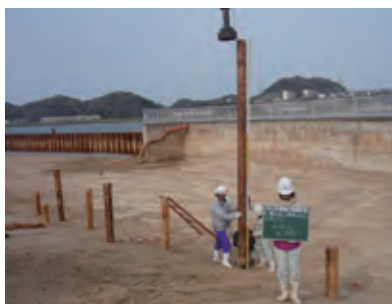
干潟の杭 設置状況
