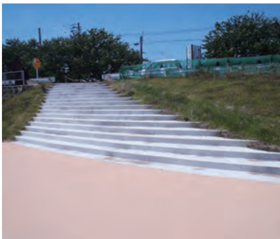
下流側の階段。踏面の幅が場所によって異なるため、職人さんに専用のコンクリート型枠をつくって施工していただきました
