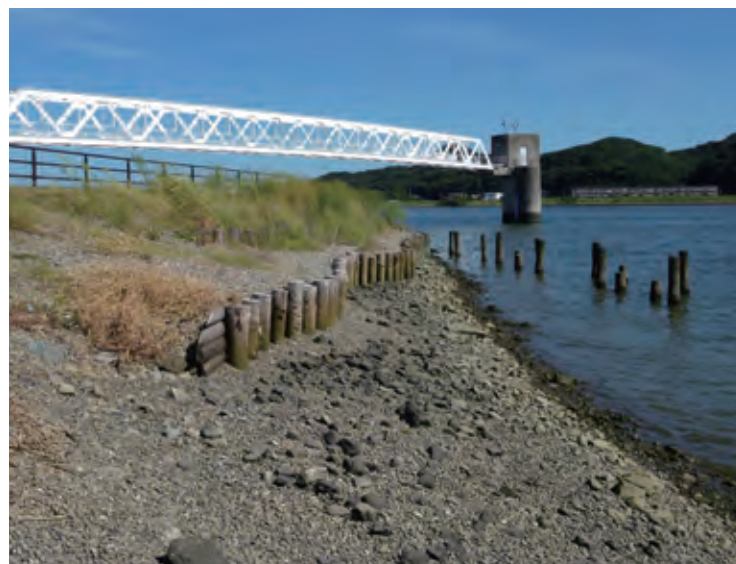
施工後の様子
