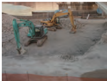
固定堰取り壊し前
