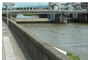
●田川市伊田地区 パラペット堤防(左:整備前、右:整備後)
