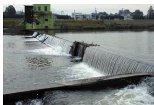
●改築前の中間堰
