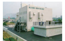
●新設された明星寺川排水機場
