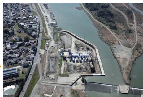
●改築工事中の中間堰(平成27年2月現在)
