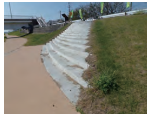
写真-6 階段工 (完成写真)
