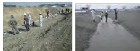
写真-10 施工業者と現地打ち合わせ状況
