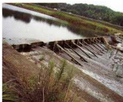
改修前の岡森堰
