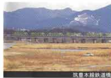
筑豊本線鉄道橋
