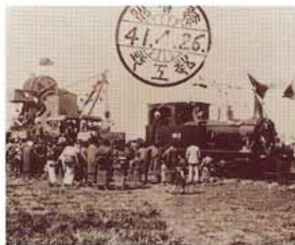
明治41年(1908)第一期改修工事起工式(直方市)
