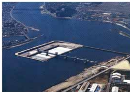
河口堰第4期工事(昭和53年5月)
