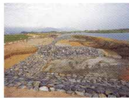
多自然型川づくり（施工中）
