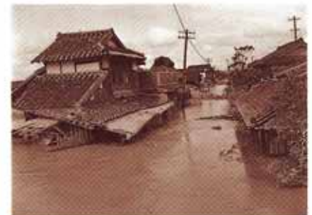
昭和28年遠賀村の被害
