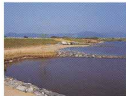
多自然型川づくり（施工後）
