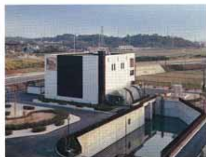
庄司川排水機場（施工後）
