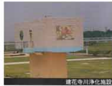
蓮花寺川浄化施設
