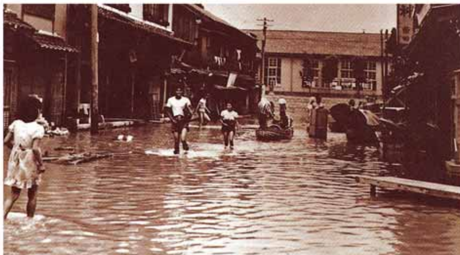
昭和28年遠賀村の被害
