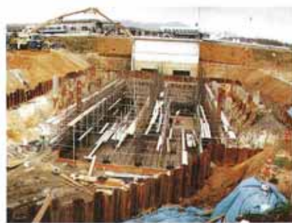
庄司川排水機場（施工中）
