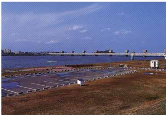
遠賀川河口堰
