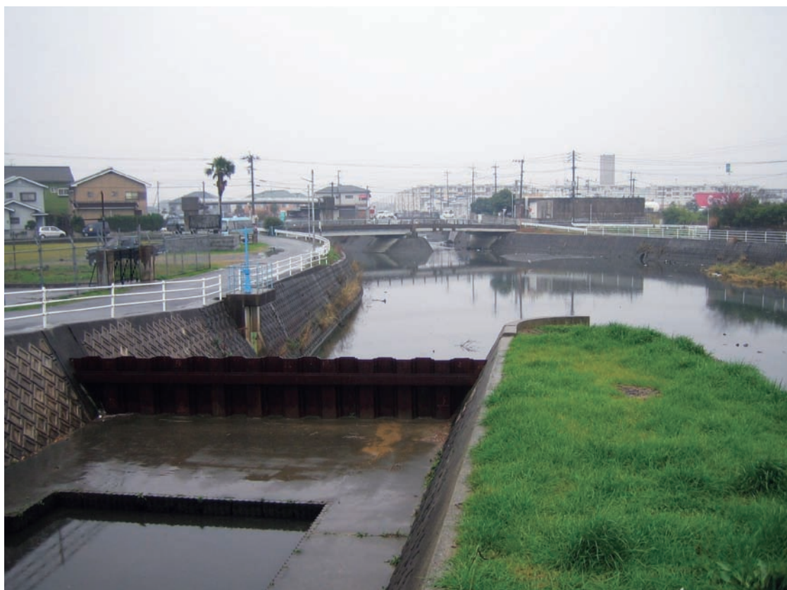
遠賀堀川：中間市岩瀬付近(平成19年12月)
