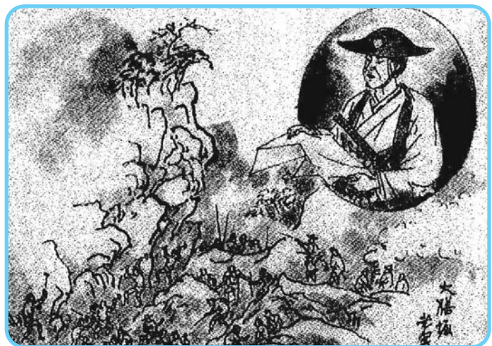
「大膳堀」の工事の指揮をする栗山大膳 (『筑紫遺愛集』より)
