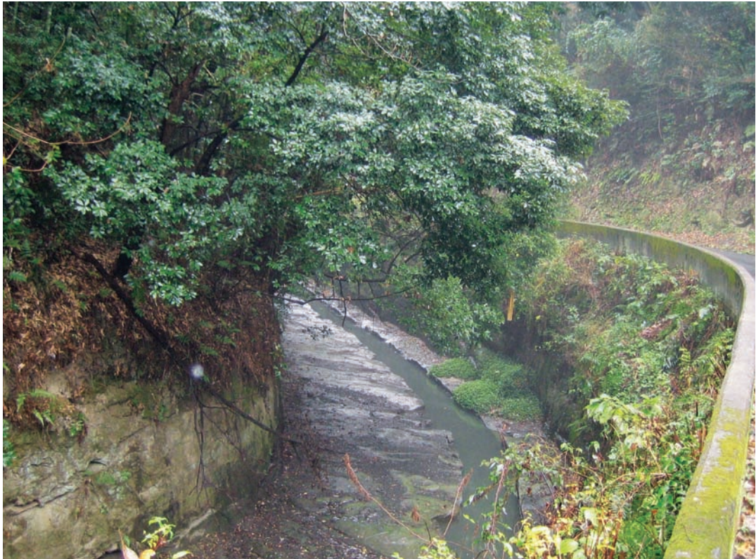
© 遠賀堀川：北九州市八幡西区大膳(平成19年12月)
