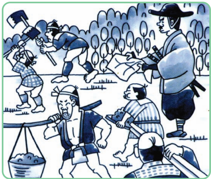
遠賀堀川の工事を指揮する櫛橋又之進（河守神社の陶板の絵）
