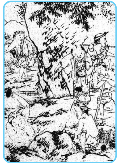
車返の工事のようす （『筑紫遺愛集』より）
