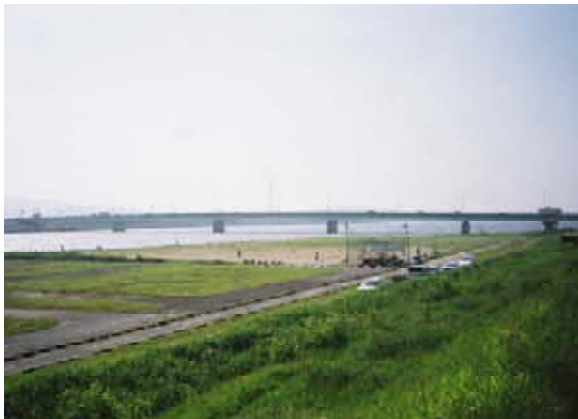
写真2. 2. 27 河川敷広場(中間市)
