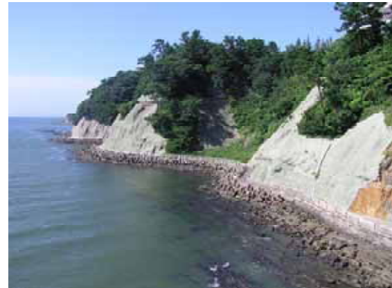
写真2. 2. 30 波懸け遊歩道(芦屋町)
