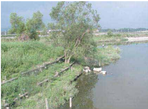
■自然に配慮した川づくり事例
