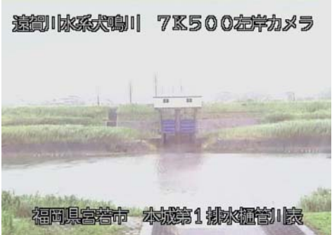
CCTVによる施設の確認
