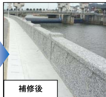
【パラペット堤防補修事例】
