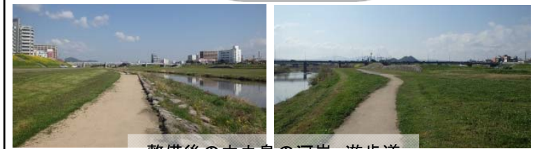
整備後の中之島の河岸、遊歩道
