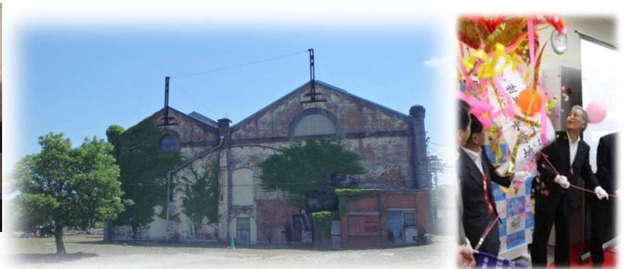
遠賀川水源地ポンプ室 ※非公開施設のため、敷地内への立ち入りは不可
