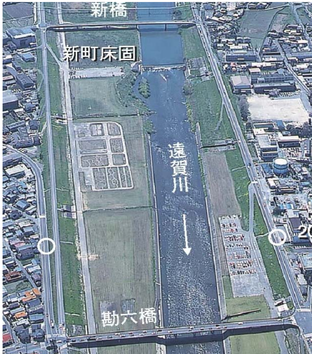
改修前：H13年3月撮影
