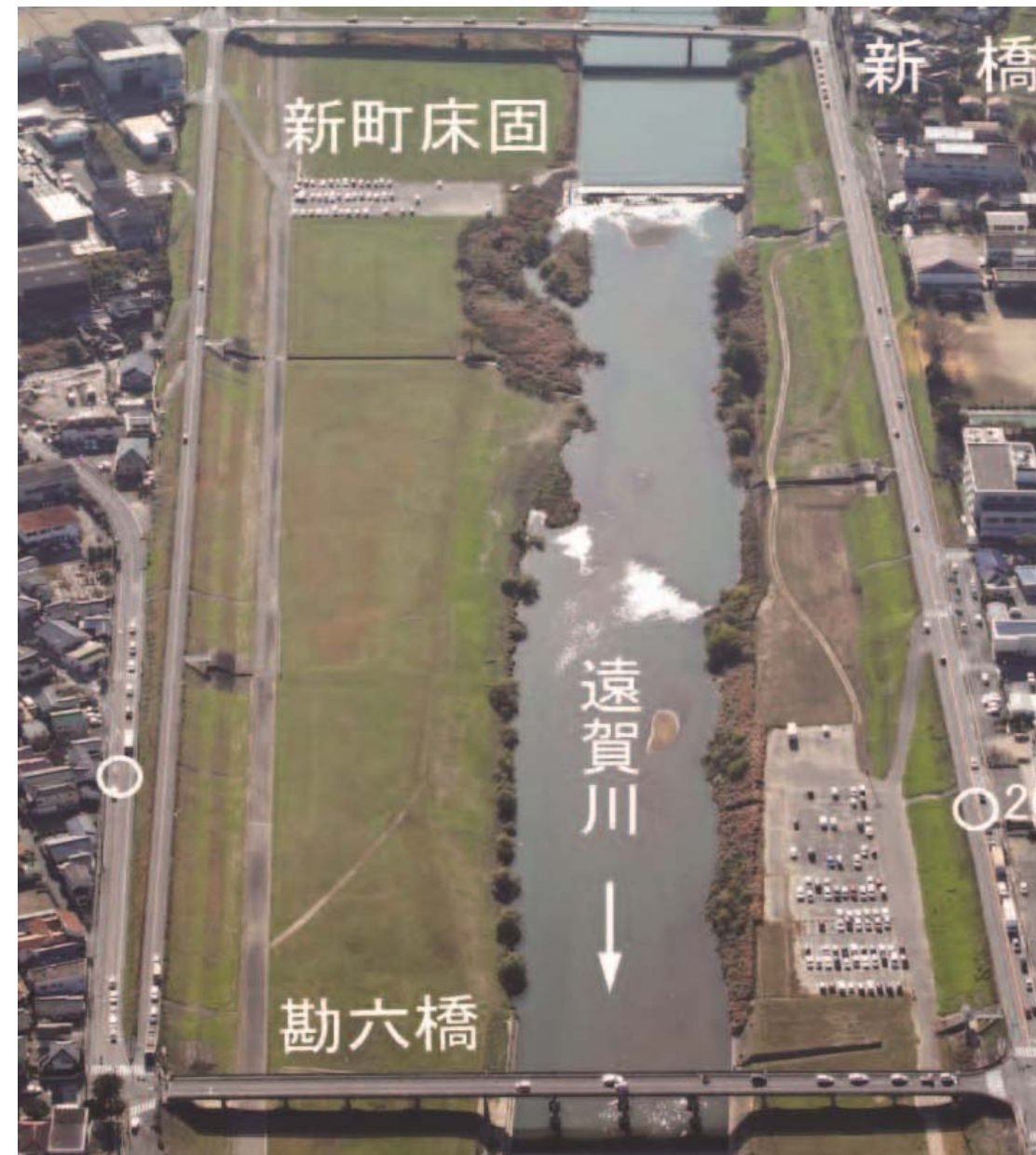
改修後：H21年5月撮影
