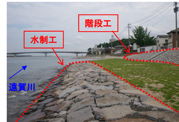
芦屋地区水辺整備箇所
