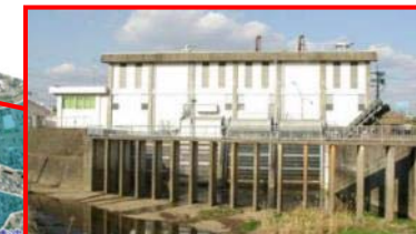
菰田排水機場ポンプ増設(+5m3) 15m3/s→20m3/s (H21年度完成)
