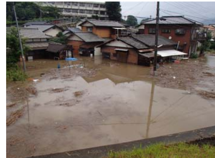
猪久保地区浸水状況 (平成24年7月)
