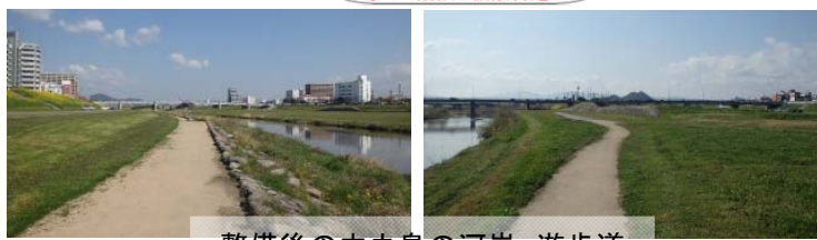
整備後の中之島の河岸、遊歩道
