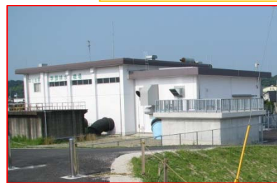
学頭排水機場ポンプ増設(+8m3) 10m3/s→18m3/s(H19年度完成)
