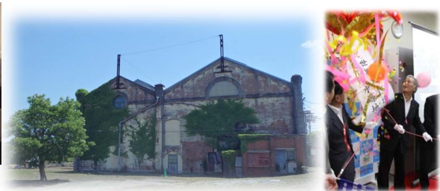
遠賀川水源地ポンプ室 ※非公開施設のため、敷地内への立ち入りは不可
