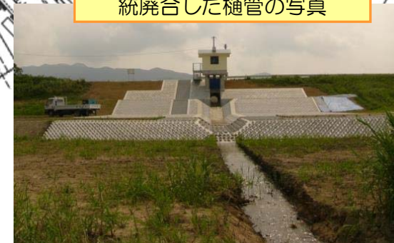
統廃合した樋管の写真
