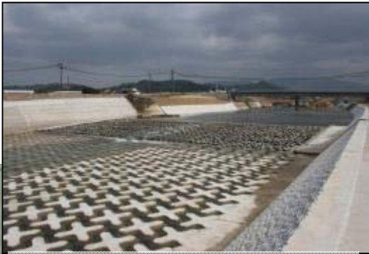
・堰の統合に伴い、床固工として復旧
