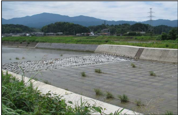
・堰の統合に伴い、床固工として復旧
