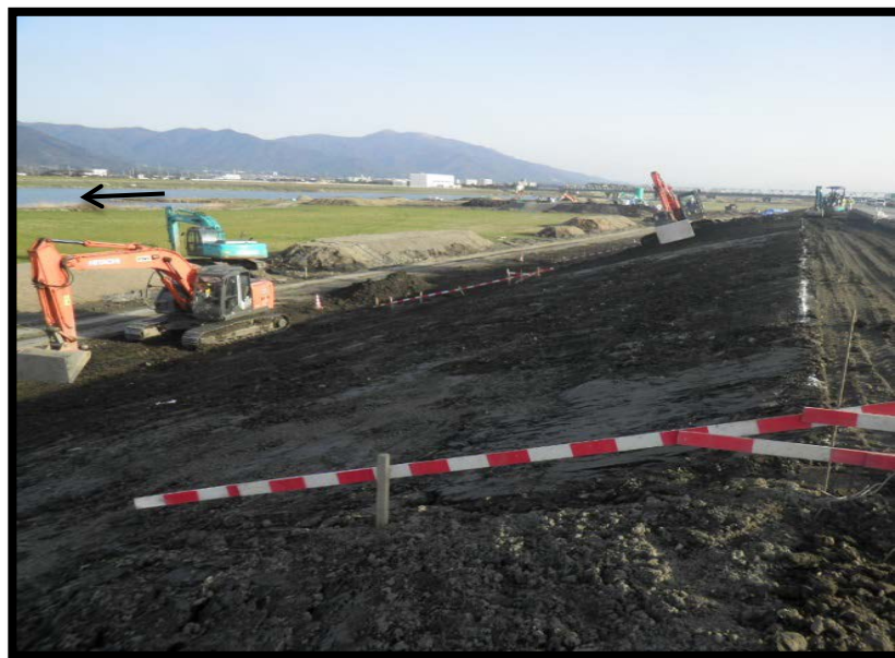
堤防腹付けへの有効活用(本川下流部)
