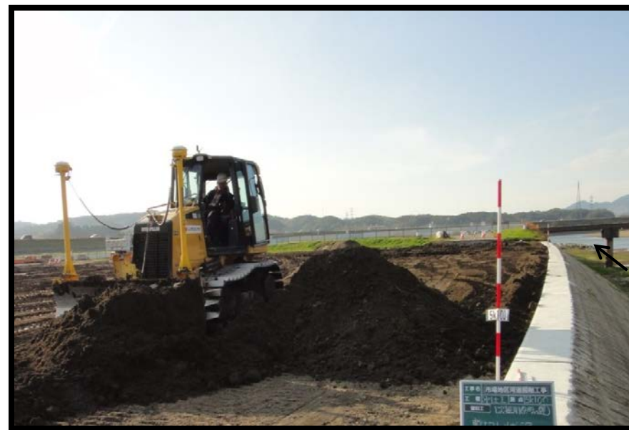
高水敷整地状況(市場地区河道掘削)
