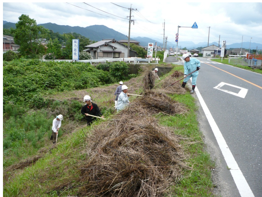
多くの作業員を必要とする除草作業
