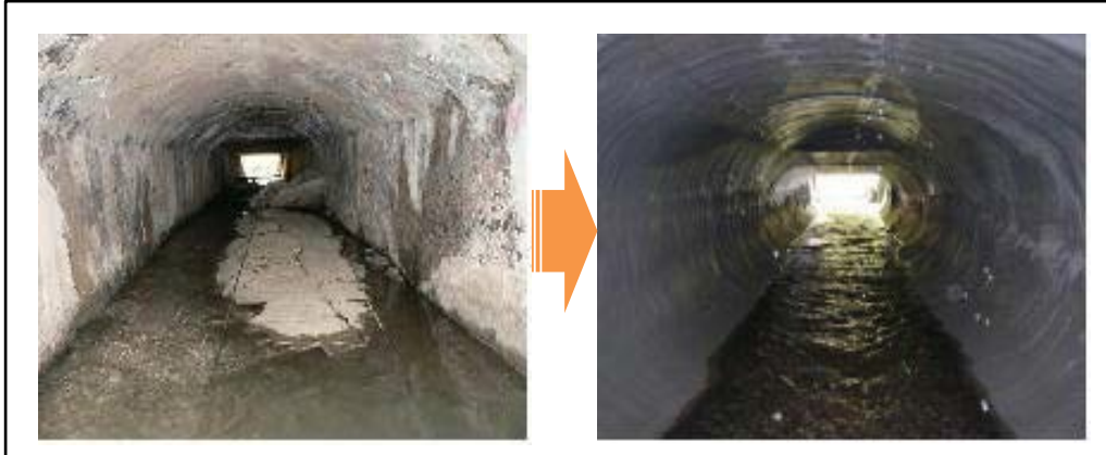
老朽化した樋門管体の補修
