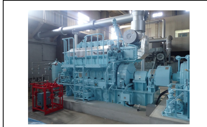
老朽化した排水ポンプのエンジンの更新
