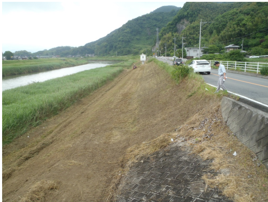
急な勾配の堤防のり面の状況
